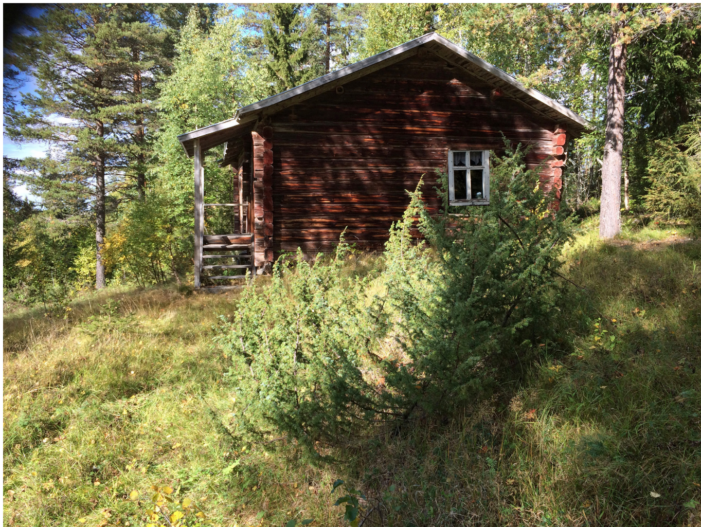
Maurlidens första hus, byggt 1804 av nybyggaren Lars Olofsson.
